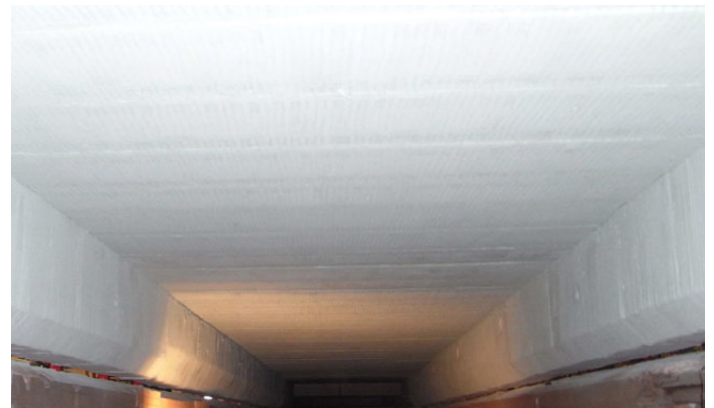
EXEMPLE DE REMPLACEMENT DE L'ISOLATION
